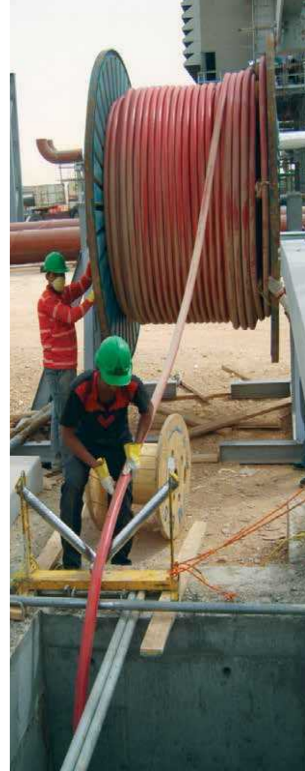
تمديد الشبكة الكهربائية، القوات البحرية بمنطقة جازان
