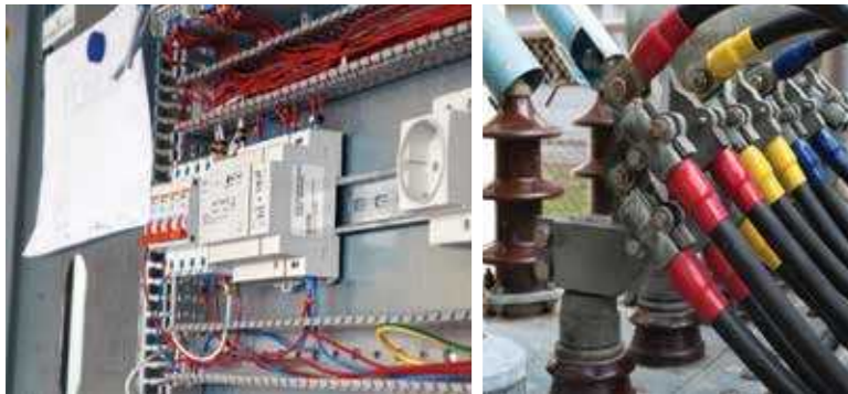
تنفيذ الأعمال الكهربائية وكابلات التحكم بمصنع شركة اسمنت تبوك
