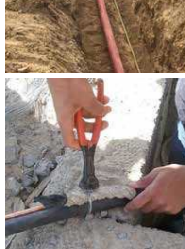
تمديد كوابل الضغط المتوسط لمعسكر قوات الطوارئ الخاصة بمنطقة الجوف
