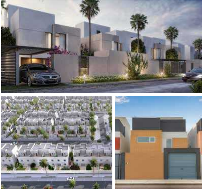
تصميم وتنفيذ مخططي إسكان الغزاله بمنطقة حائل وإسكان خوارم بمحايل عسير، الشركة الوطنية للإسكان
